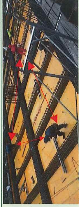
作業員の配置をブロック分けし密接した作業を回避
